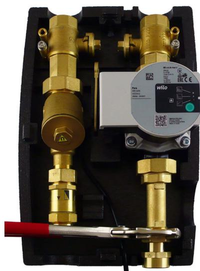
Na vratné potrubí namontujte prodloužené šroubení se zpětným ventilem 18653.
