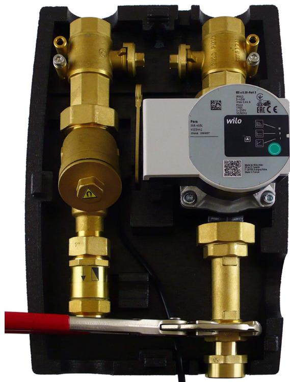
Místo původních šroubení namontujte šroubení 17920 , určené pro montáž k rozdělovači.
